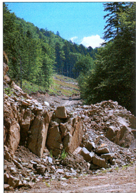
Budowa drogi do oddziału 59b, gdzie do tej pory nie prowadzono zabiegów gospodarczych.
