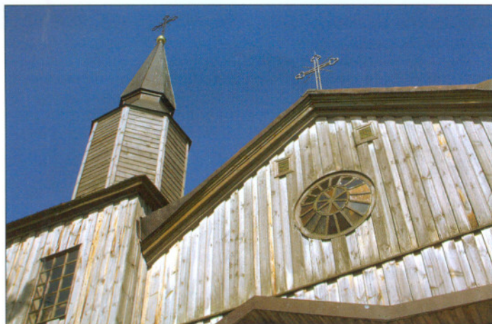
Drewniany 130-letni kościół w Jeleniewie. To właśnie tu zadomowiła się największa w Polsce kolonia lęgowa nocka tydkowatośego, najbardziej zagrożonego gatunku nietoperza w Europie. Kościół wymaga pilnego remontu i powinien on być wykonany w takim terminie, aby nie zaszkodził kolonii ncocków.
